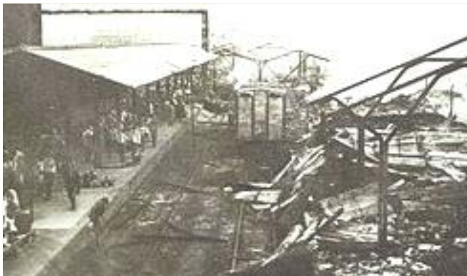
1945年8月8日深夜 空襲を受けて瓦礫と化した福山駅舎
